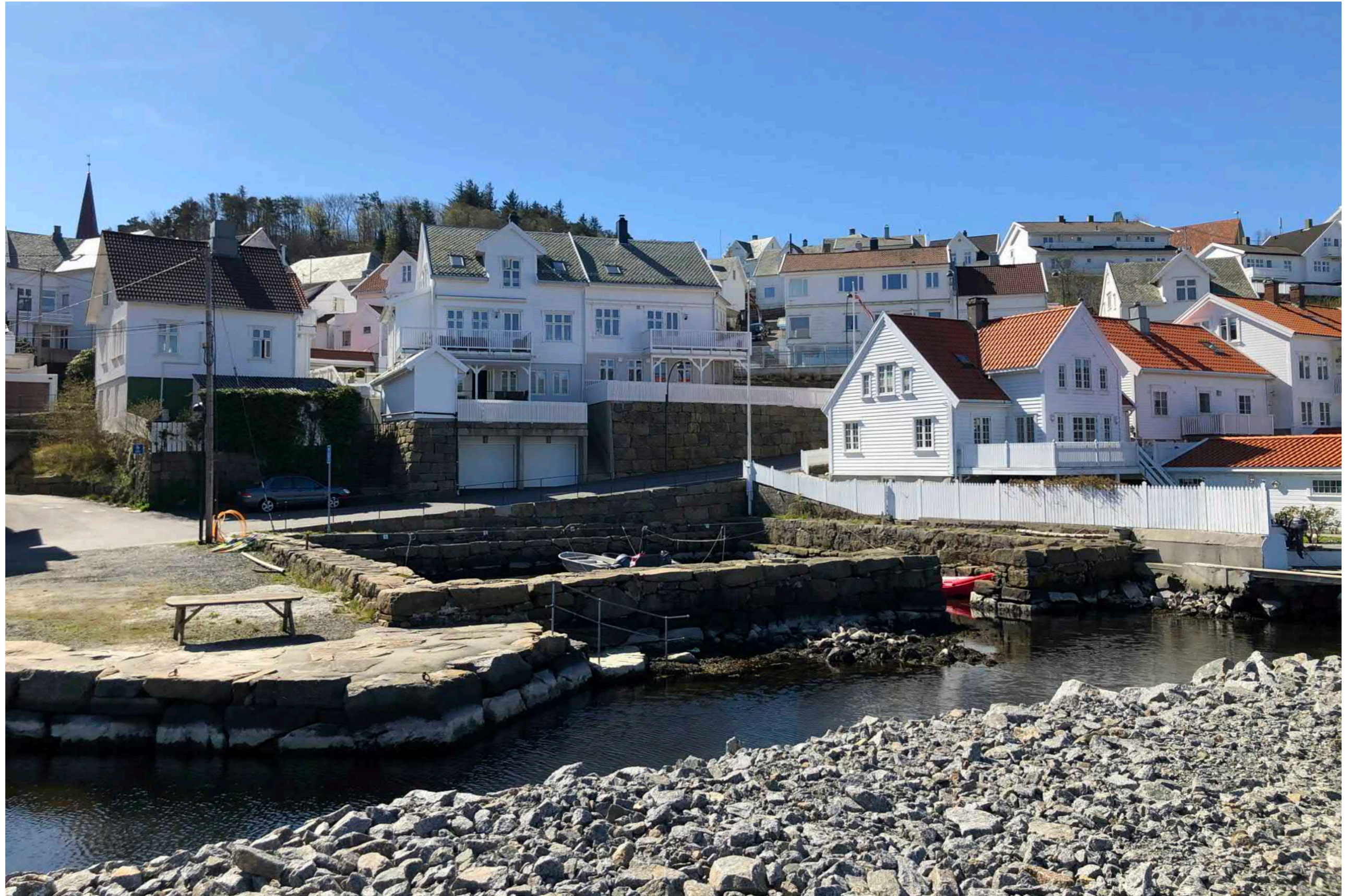
Foto av utfylling i fjorden sett mot Vesterside april 2020
