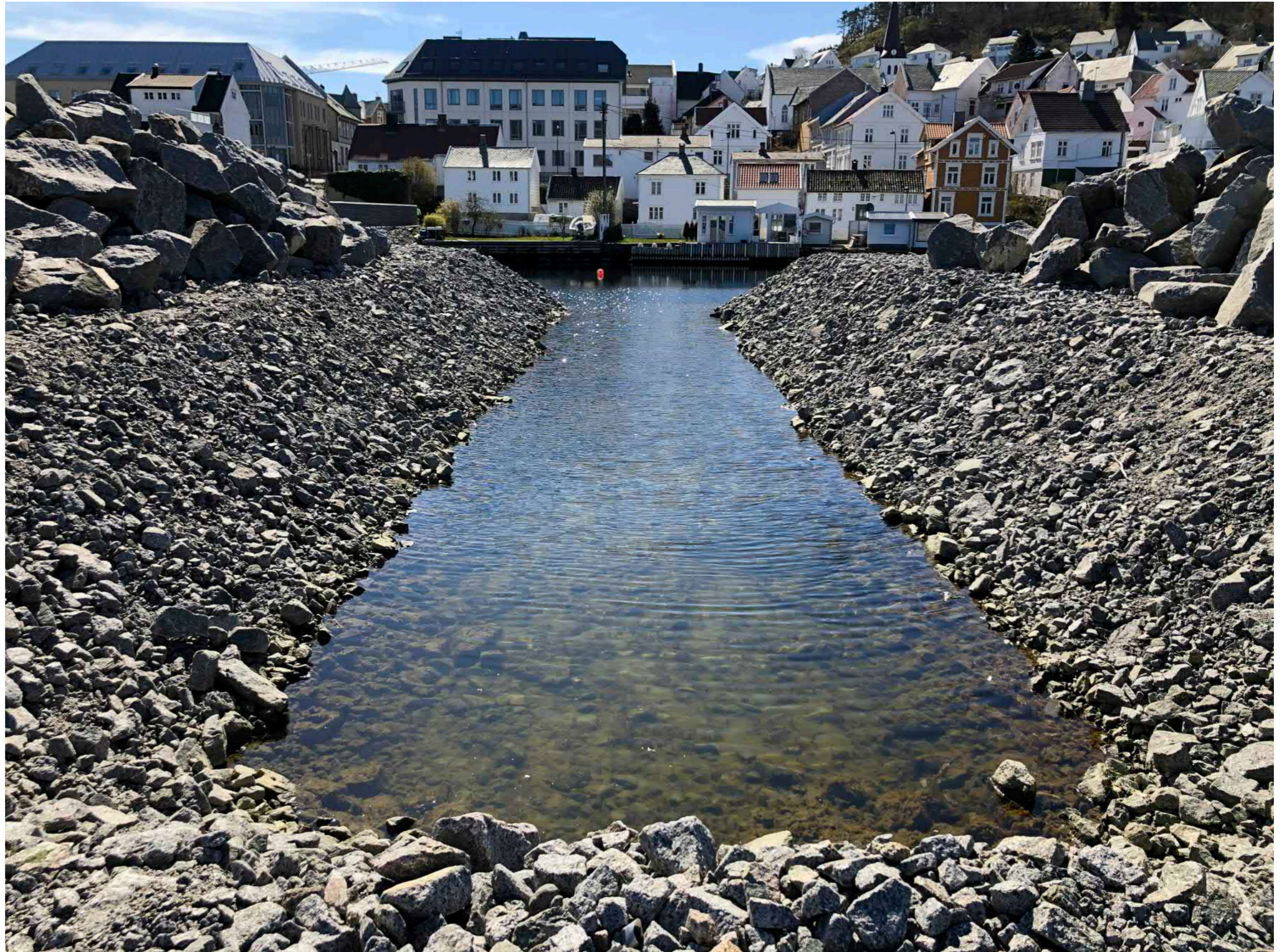
Foto av utfylling i fjorden sett mot Vesterside april 2020
