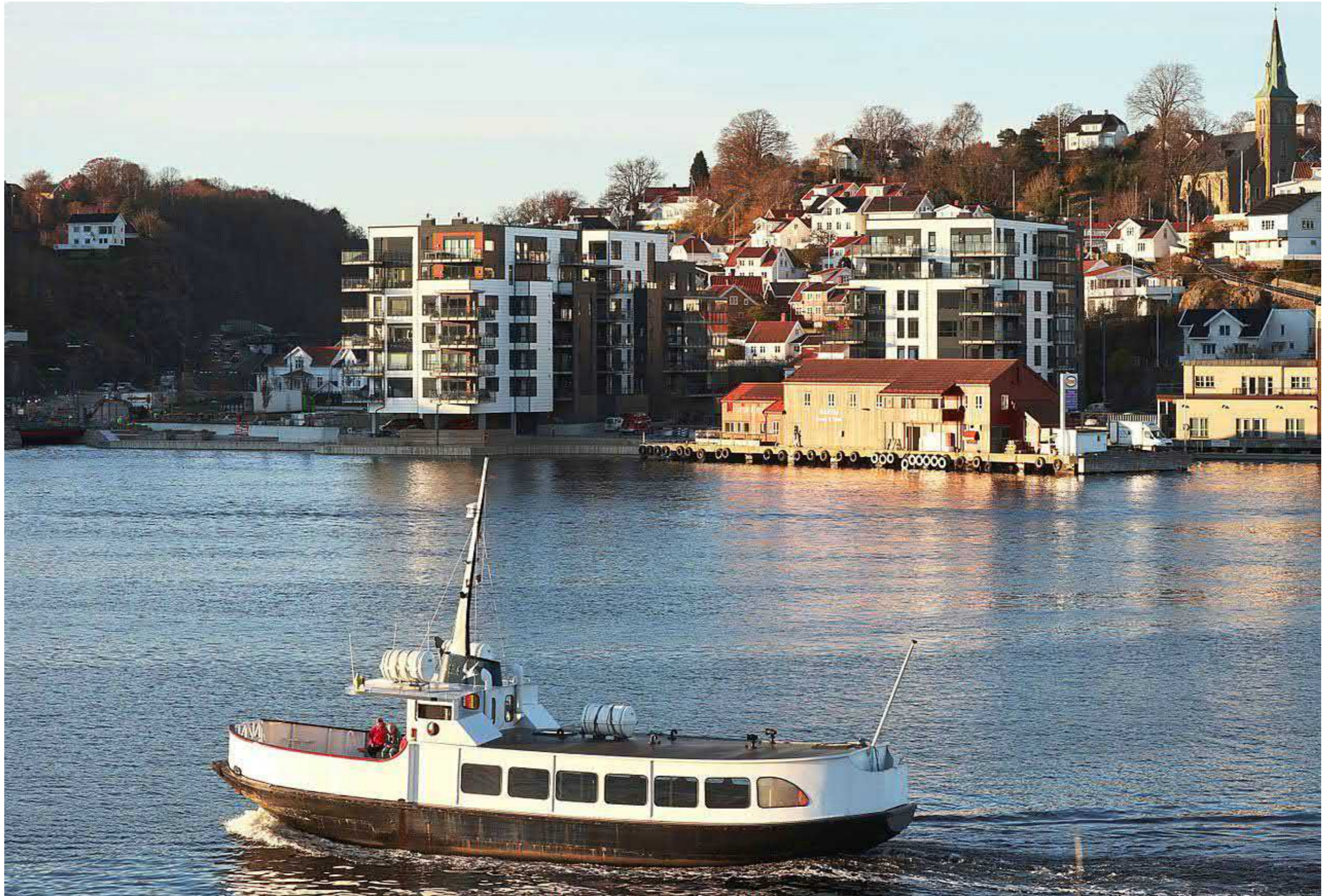
Barbu etter utbygging av nye leilighetsbygg, parken er under opparbeidelse.
