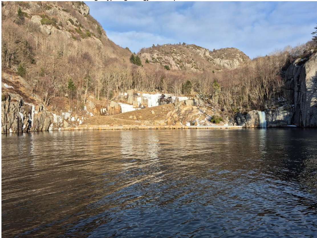
Over: bildet tatt fra sjøen som viser omfanget av utfylling.
